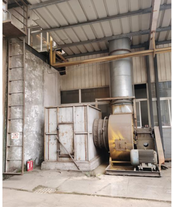
图 10 面漆工序排气筒 (DA006)
