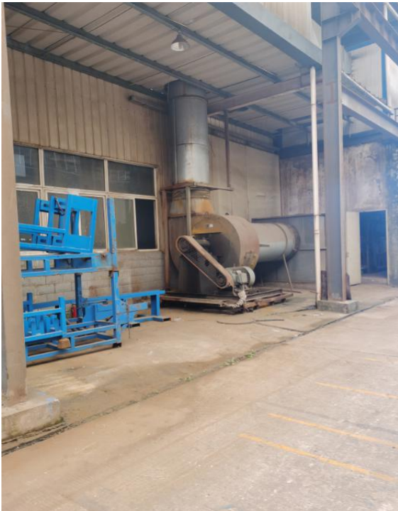
图 11 面漆工序排气筒 (DA007)
