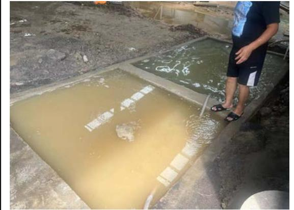
图 3 车辆冲洗废水处理设施(沉淀池)
