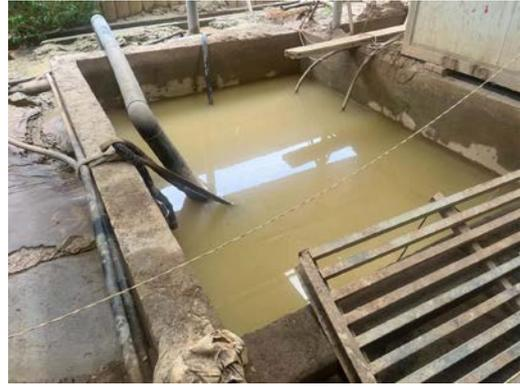
图 2 设备冲洗废水处理设施(沉淀池)
