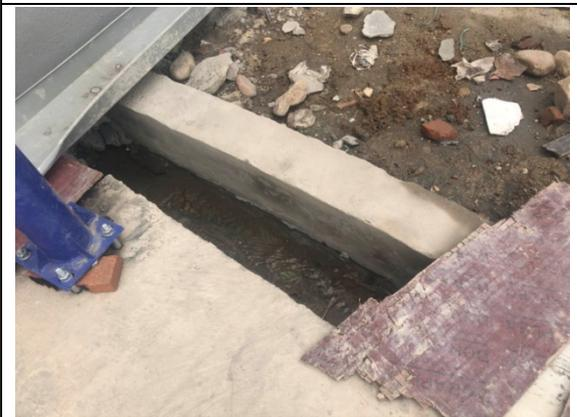
图 5 雨水管网(明渠)
